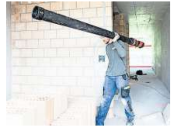
Sanitär mit Rohr bei der Arbeit. Symbolbild: Manuela Jans-Koch
